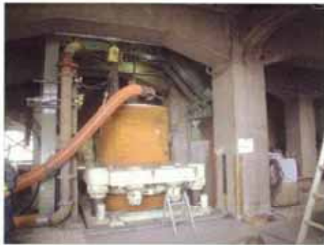
低空頭施工例(三翼ビット型)(JR)
