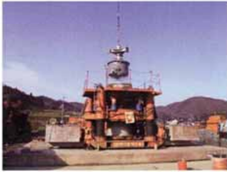
粘板岩掘削試験
