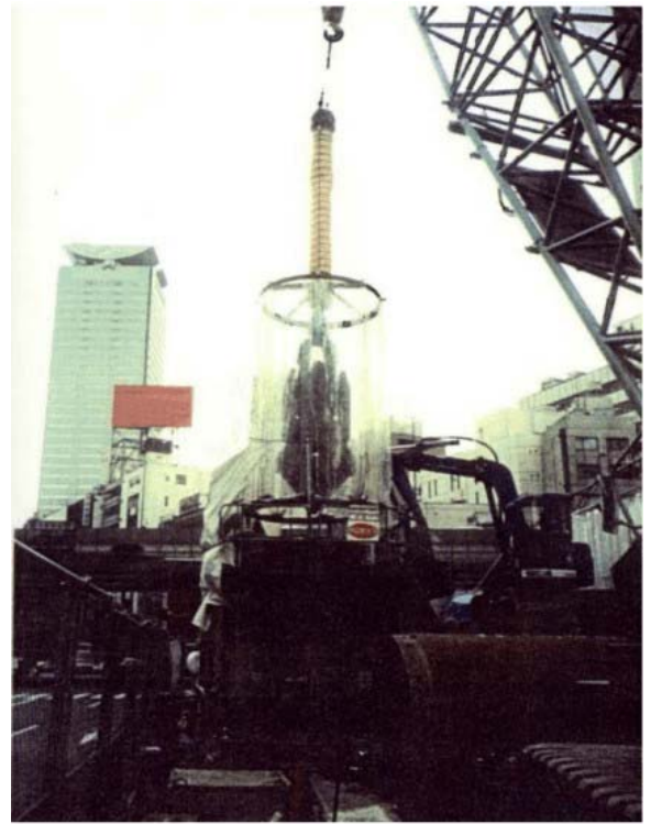
ハンマグラブ泥土泥水 飛散防止装置
